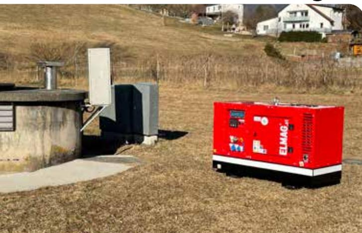
Notstromaggregat der Marke ELMAG wird mit dem Treibstoff Diesel betrieben, hat eine Leistung von 18 kVA und wurde von der Firma Eisenhuber geliefert.
