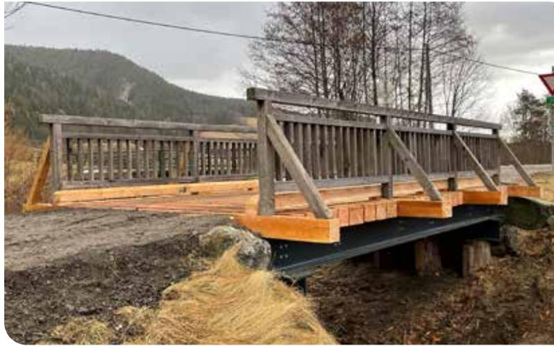
*Die Brücke über den Lehenbach kurz vor Otterthal wurde 2008 errichtet und ist im Jahr 2020 leider gebrochen. Im Winter haben die Gemeindearbeiter mit der Schlosserei Fuchs eine Eisenkonstruktion anstelle der Holzträger eingebaut und die Brücke neu belegt.*
